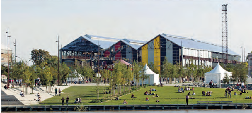
Les Nefs de la Loire, Parc des chantiers, Ile de Nantes. État des lieux, avril 2006. Projet, septembre 2008. Projet : Alexandre Chemetoff & associés
