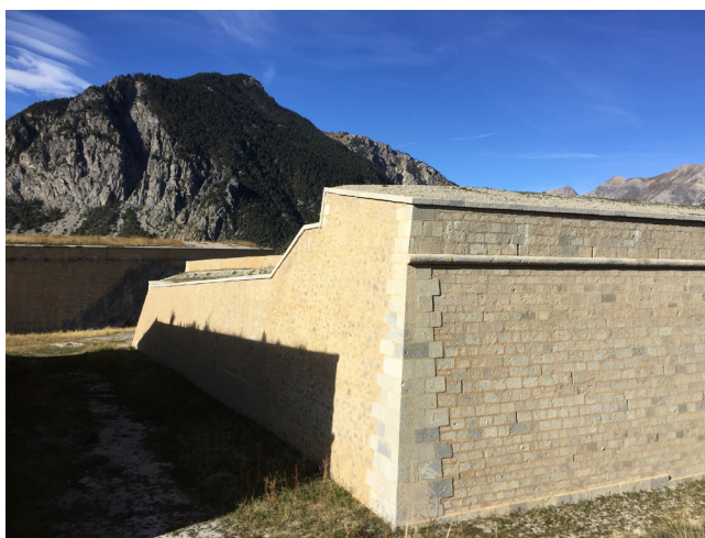
La courtine du Front Royal du Fort des Têtes à Briançon (Hautes-Alpes) (classée au titre des monuments historiques (façades et toitures) par arrêté du 08/06/1989) © DRAC PACA / CRMH
