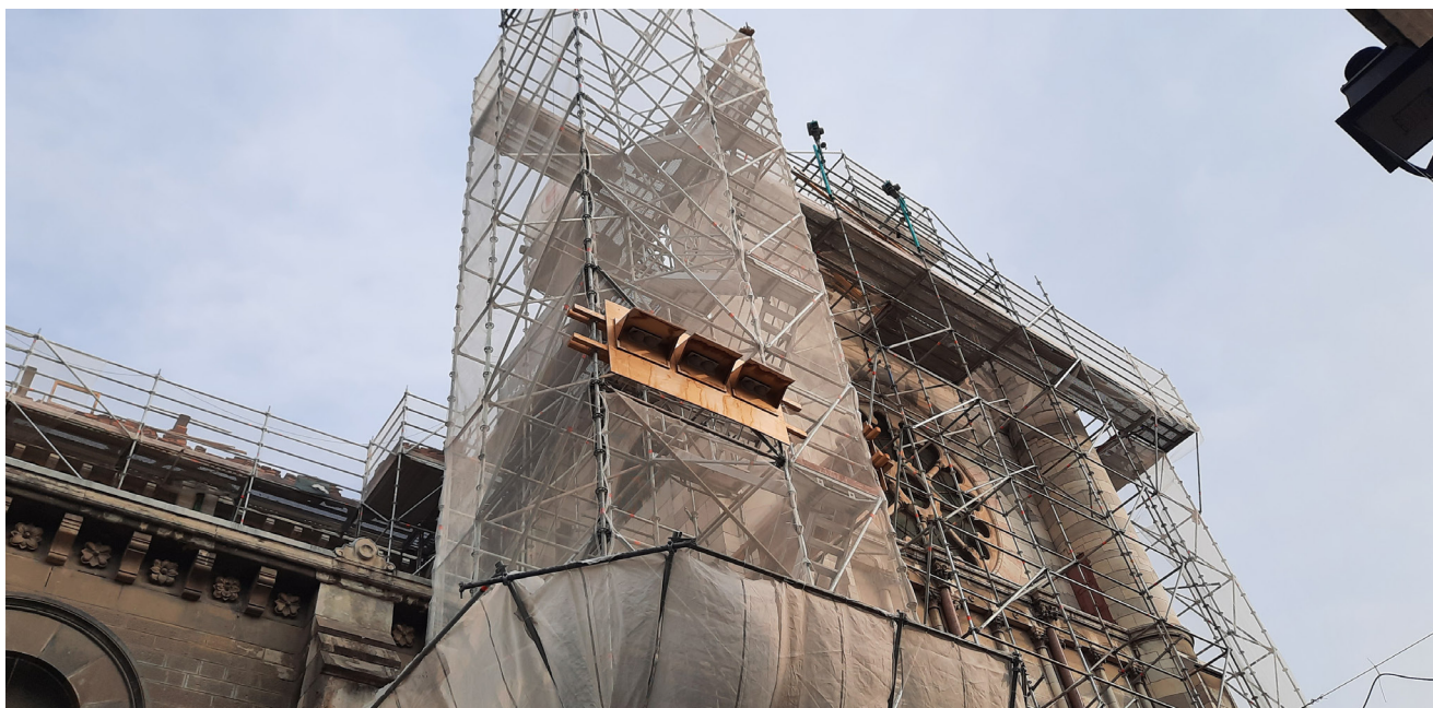
Restauration de la cathédrale Saint-Arnoux, présence des nichoirs sur échafaudage, Gap (Hautes-Alpes) © DRAC PACA / CRMH
