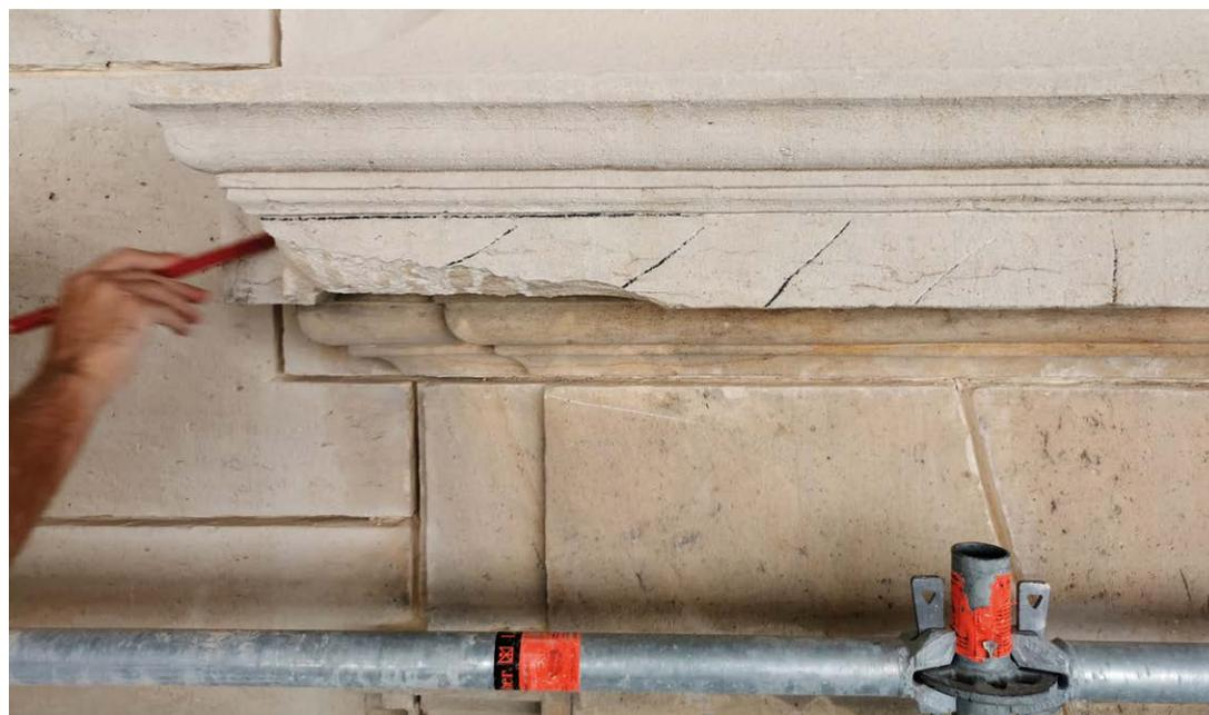
Repérage pour une réparation par greffe localisée d'une corniche en pierre. La technicité est le moyen de la limitation des renouvellements de matière, au bénéfice du patrimoine et de l'impact carbone du chantier de restauration.
