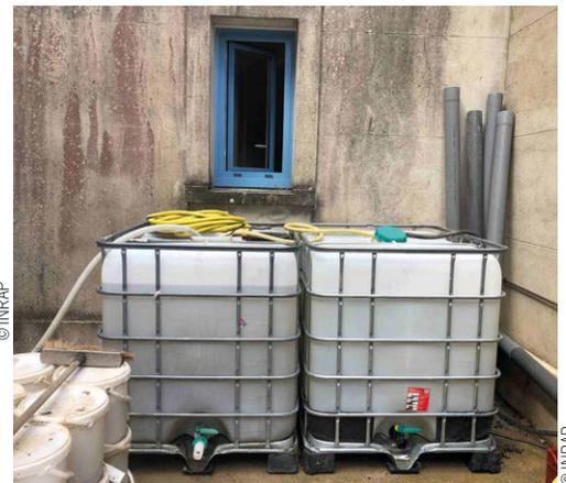
Cuve de gauche : premier traitement des eaux récupérées à l'oxygène actif ; cuve de droite : second traitement réduisant considérablement la turbidité de l'eau.
