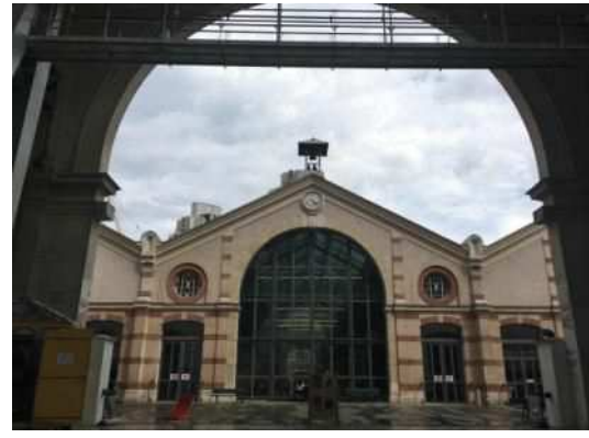
Entrée cour d'Aubervilliers
